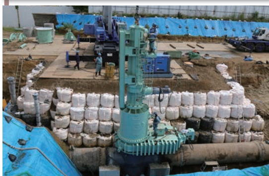
白山浄水場配水本管更新工事
