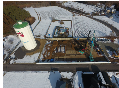
ひばり野配水塔（写真左）の隣に築造中の 新ひばり野配水塔と配水池（五戸町）
