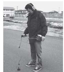
漏水調査の様子
