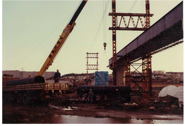
写真5 西水管橋の施工状況②
