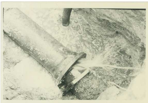
写真3 水道管の被害状況（継手の抜け出し）
