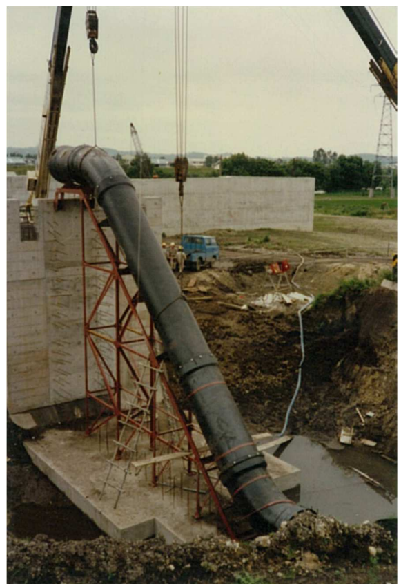
写真9 水管橋下部の配管②
