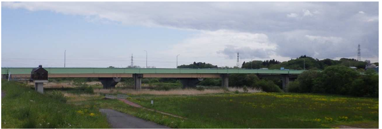
写真 11 令和 6 年（2024 年） 西水管橋の状況
