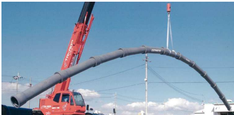
写真12 耐震形ダクタイトイル鉄管(GX形)の吊り上げ状況
