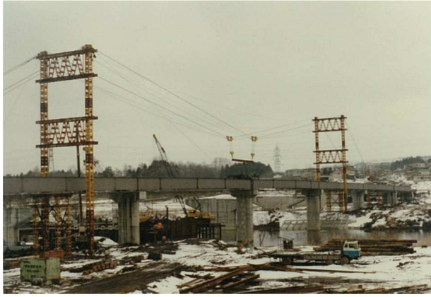
写真4 西水管橋の施工状況①
