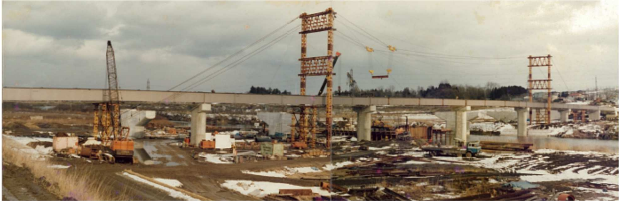
写真 10 昭和 52 年（1977 年） 西水管橋の施工状況
