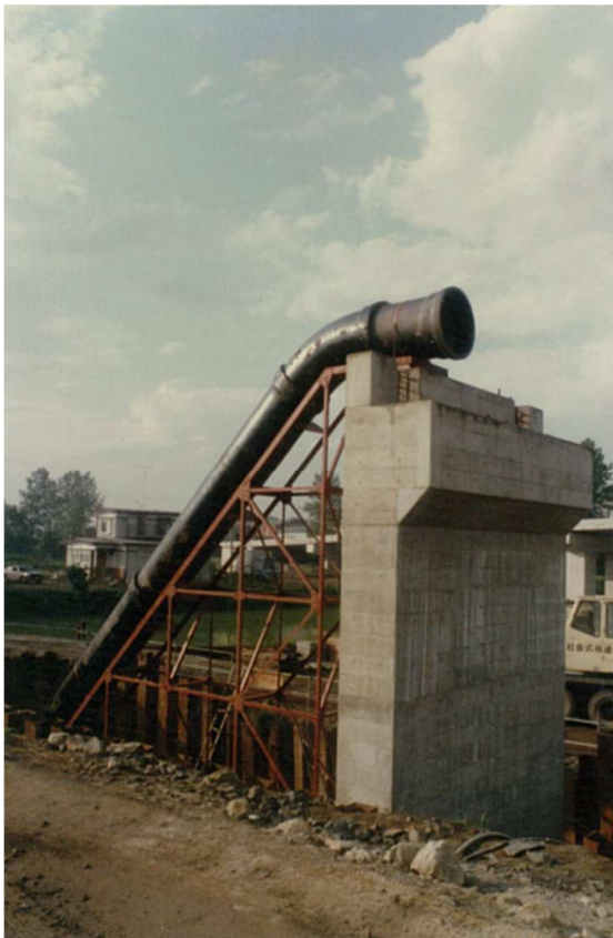
写真8 水管橋下部の配管①
