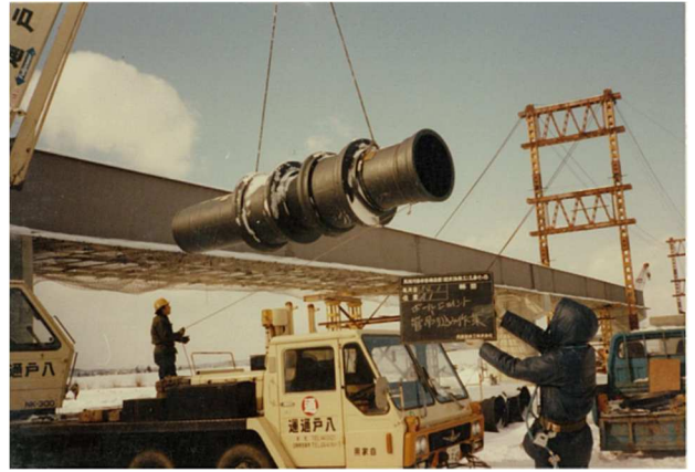
写真7 耐震管の施工状況②
