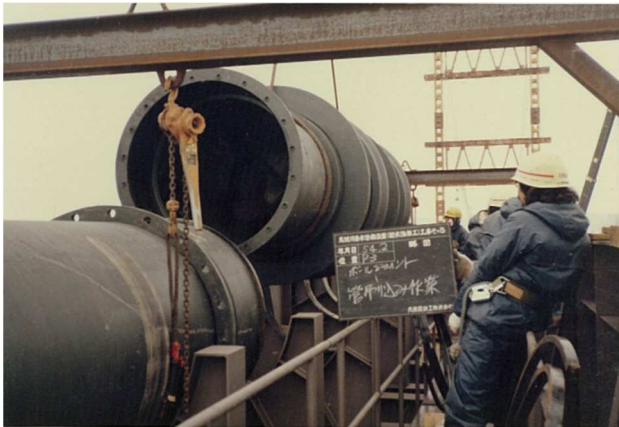
写真6 耐震管の施工状況①
