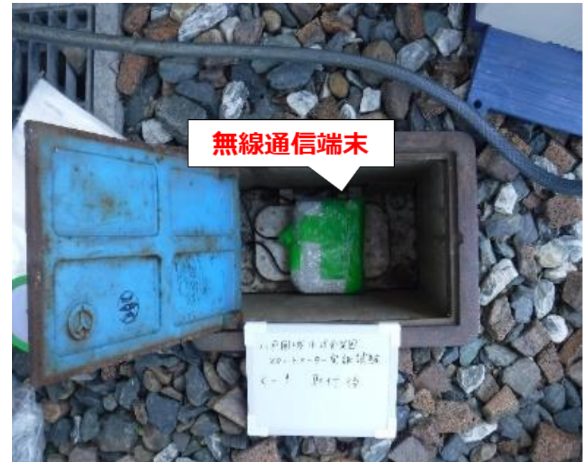
ビニール養生
