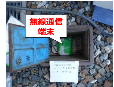
ビニール養生
