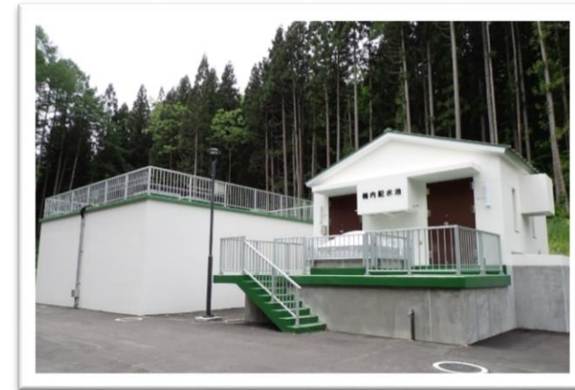
梅内(新目時)配水池
