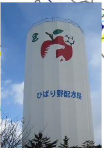
既存の ひばり野配水塔 平成元年 700 m 3
