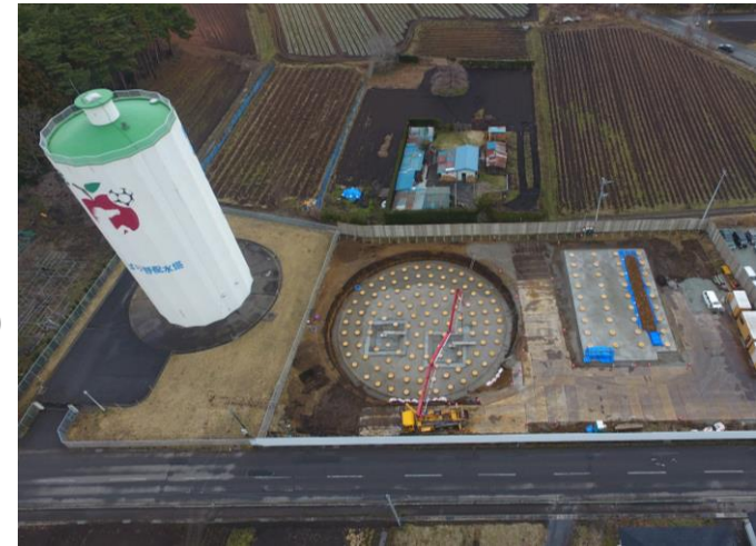
新ひばり野配水塔・配水池築造工事
