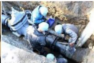
復旧作業の様子
