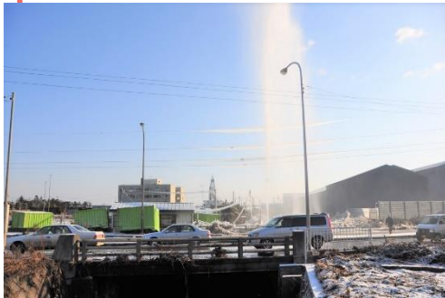
漏水（東日本大震災）
