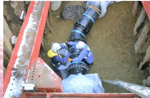
導水管・復旧工事
