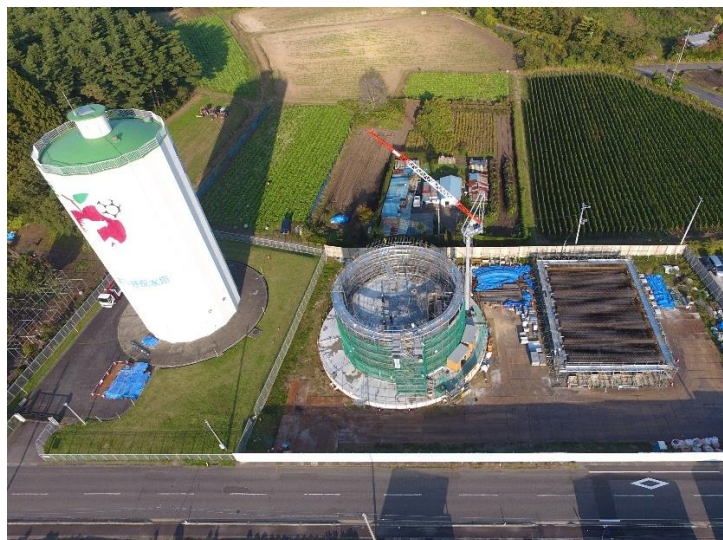
建設中のひばり野2号配水塔・配水池(令和6年度 着工)
